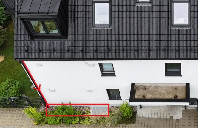
Leitungsführung im Außenbereich
